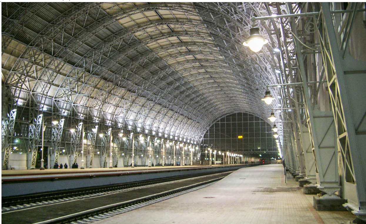
Рисунок 6 – Металлические конструкции Шухова в здании вокзала
